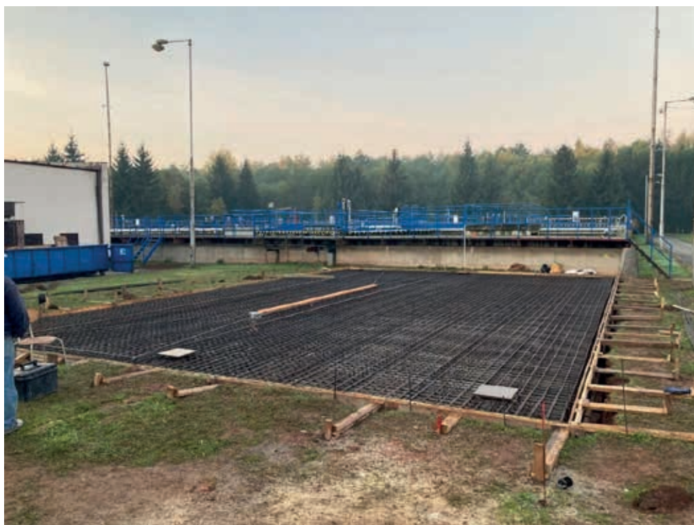
Obrázek 1 – Výstavba základové desky pod jednotku integrovaného hrubého předčištění
