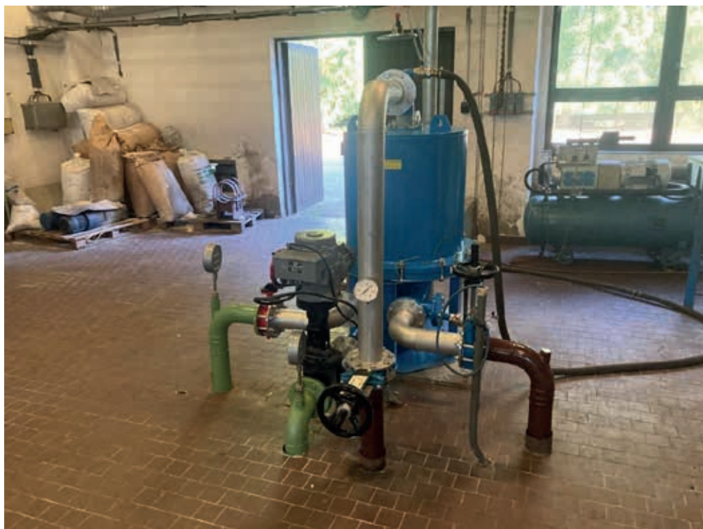
Obrázek 3 – Kalový výměník pro ohřev kalů ve vyhřívací nádrži
