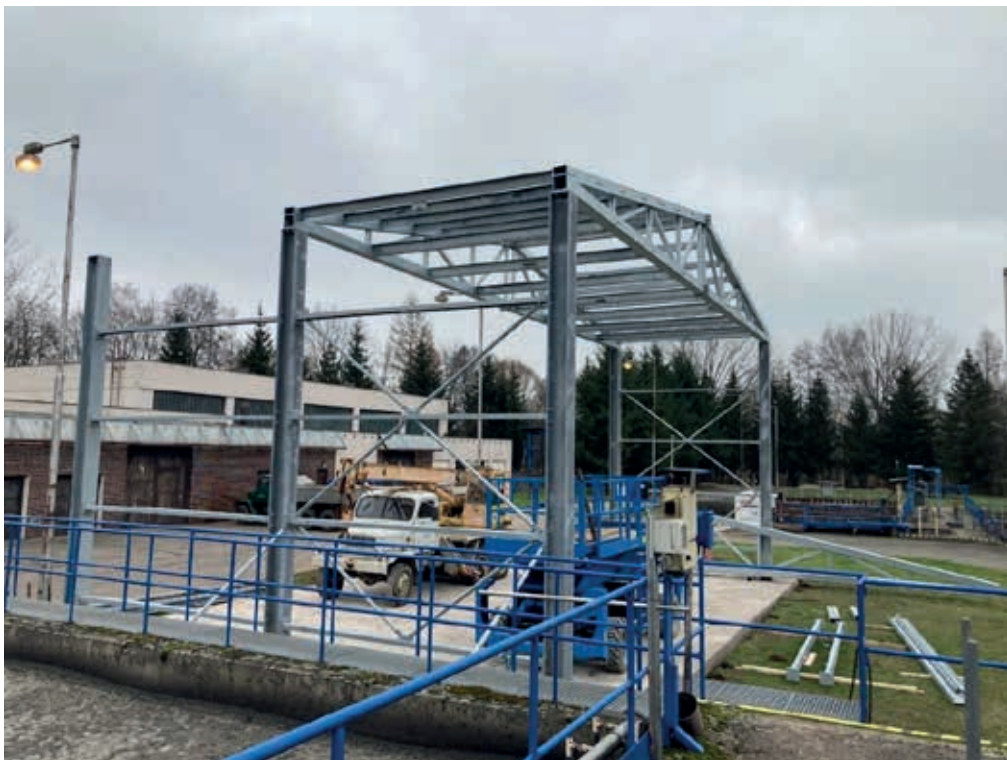
Obrázek 2 – Montáž ocelové konstrukce zastřešení
