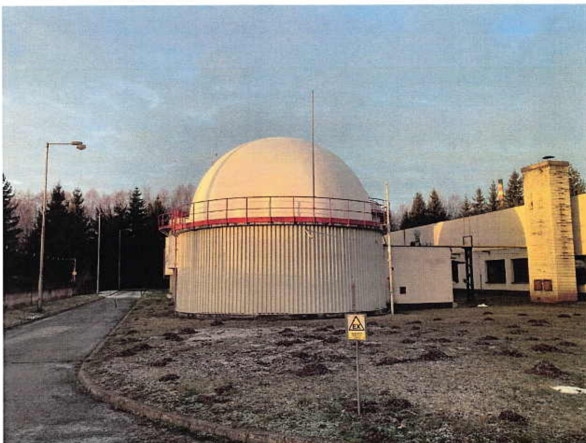
Obr. č. 2 – Rekonstruovaný plynojem
